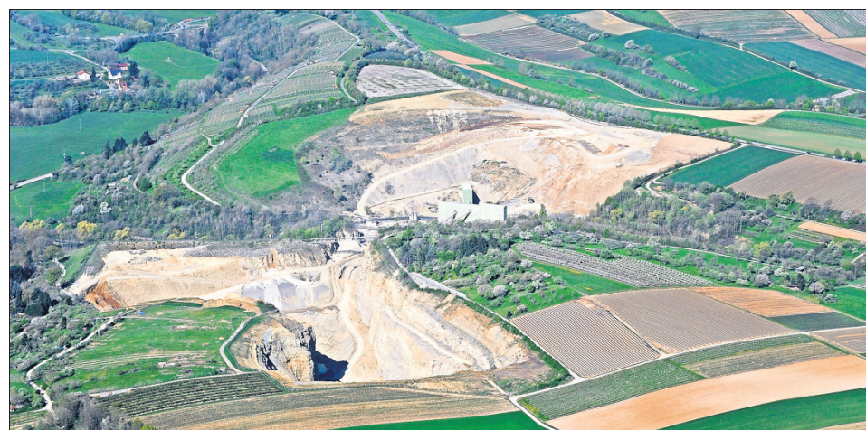
Der mobile Vorberecher soll im östlichen Abbaubereich installiert werden. Foto: Archiv (Kuhnle)
